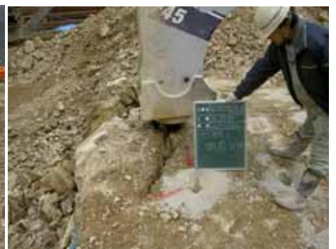
引き起こし、破碎完了。
