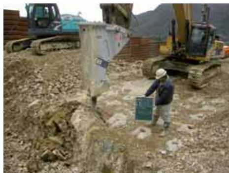
破碎状況 かち割り君による破碎(割岩力 4,900t)
